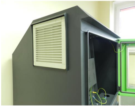
· bok szafy z kratką wentylacyjną wylotową
